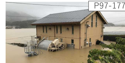
浸水した排水機場(R1.10台風19号)
