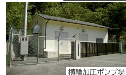
横輪加圧ポンプ場
